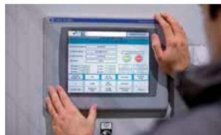
Электрощиты фильтров GHS снабжены модернизированной автоматической системой управления с интерфейсом оператор-машина (HMI), что значительно упрощает процесс мониторинга функционирования фильтра и диагностики отказов, позволяет непрерывно регулировать параметры фильтрации в зависимости от меняющихся условий фильтрационного процесса с целью оптимизации.
