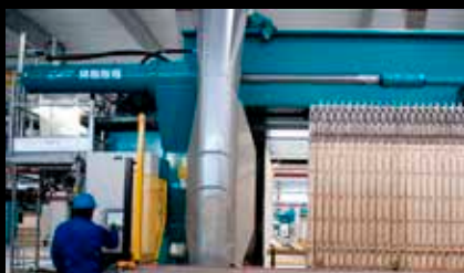
Промывка фильтровальных тканей под высоким давлением
