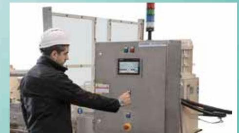
Los AUTOMAT están equipados con un sistema de automatización avanzado con interfaz operador – máquina (HMI), lo que hace mucho más sencillo el control del funcionamiento del filtro, el diagnóstico de eventuales fallas y además el control continuo de los parámetros de filtración con el fin de optimizarlos según las variables de proceso.
