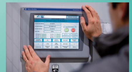
Los GHT están equipados con un sistema de automatización avanzado con interfaz operador - máquina (HMI), lo que hace mucho más sencillo el control del funcionamiento del filtro, el diagnóstico de eventuales fallas y además el control continuo de los parámetros de filtración con el fin de optimizarlos según las variables de proceso.
