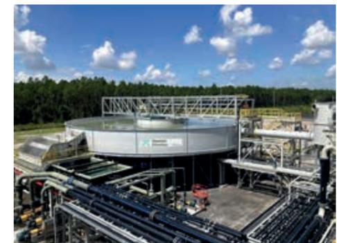
**I nostri ispessitori high-rate sono, invece, complementari ai filtri** e giocano un ruolo cruciale nel processo di trattamento dei fanghi. La loro funzione principale è quella di aumentare la concentrazione dei solidi sospesi per migliorare la filtrabilità e ridurre i tempi di ciclo, che dipendono dalla concentrazione dei solidi nel fango, aumentando la produttività e riducendo così l'investimento totale per il cliente.
